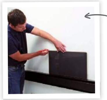
Paso 1: Comience por medir la anchura y altura de la pared. Encuentre el centro horizontal de la pared. Para definir el espaciado estándar coloque la mitad de un tablón laminado en el centro de la pared y marque los bordes izquierdo y derecho de la pieza.
