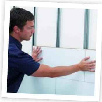
Paso 5: Coloque las siguientes filas de la misma forma. Tenga en cuenta la instalación de los cables y puntos de conexión detrás de los paneles en caso de instalar aparatos eléctricos. Podrá empezar a ver el resultado final de su construcción con los laminados ya bloqueados.
