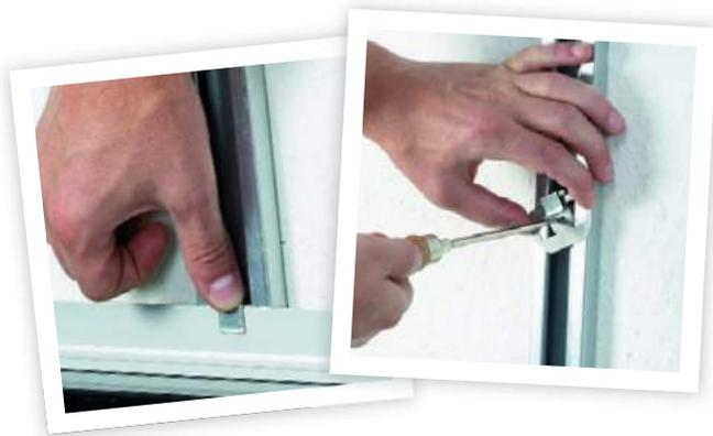
Paso 3: Coloque un clip n° 3 de montaje en un ángulo y gire en posición horizontal con la ayuda de un destornillador. Empuje el clip de instalación hacia abajo y proteja la tira de perfil n° 2.
